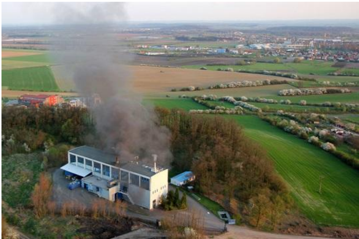
Obr. 2: Fotografie pořízená náhodou zachycuje havárii ve spalovně v Lysé nad Labem, o které se později ukázalo, že jde o problém spojený s nesouladem mezi technologií spalovny a filtrem na zachycování dioxinů (PCDD/F) dodaným firmou Evenco Brno.
